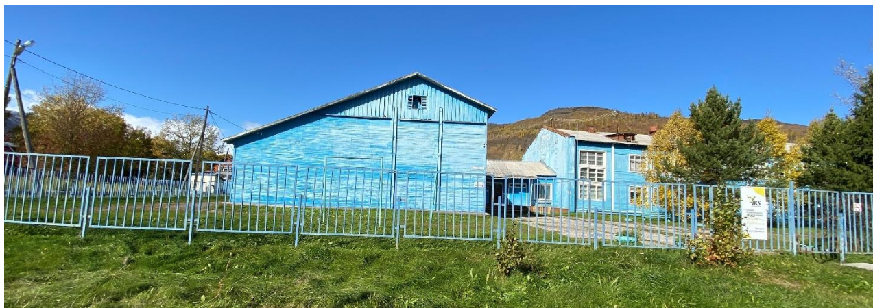
Изображение 1. Общий вид части фасада здания в осях 1-15
