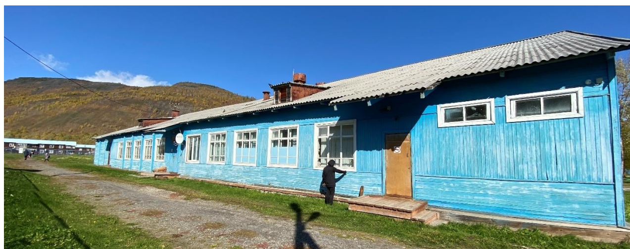
Изображение 3. Общий вид фасада здания в осях P-A
