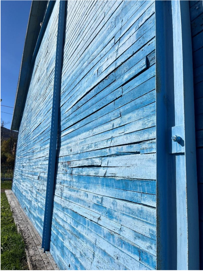
Изображение 17. Выпучивание простенков брусчатых стен
