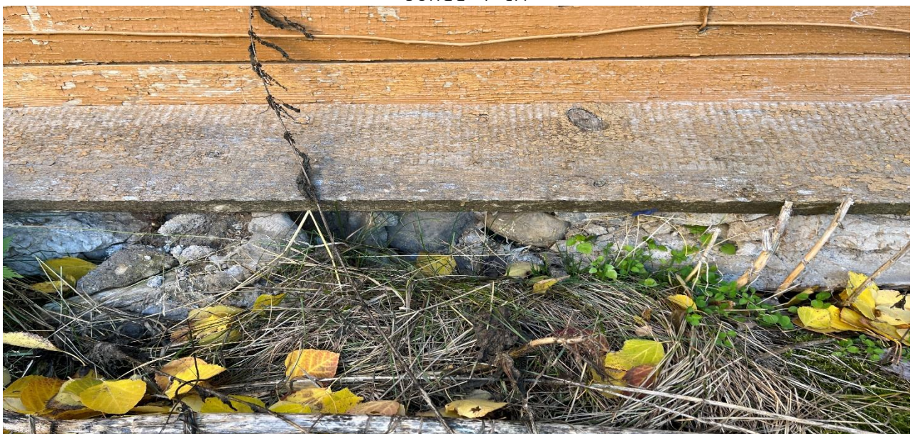
Изображение 16. Вымывание цементно-песчаного раствора. Окатанный, галечный материал, размером более 50 мм
