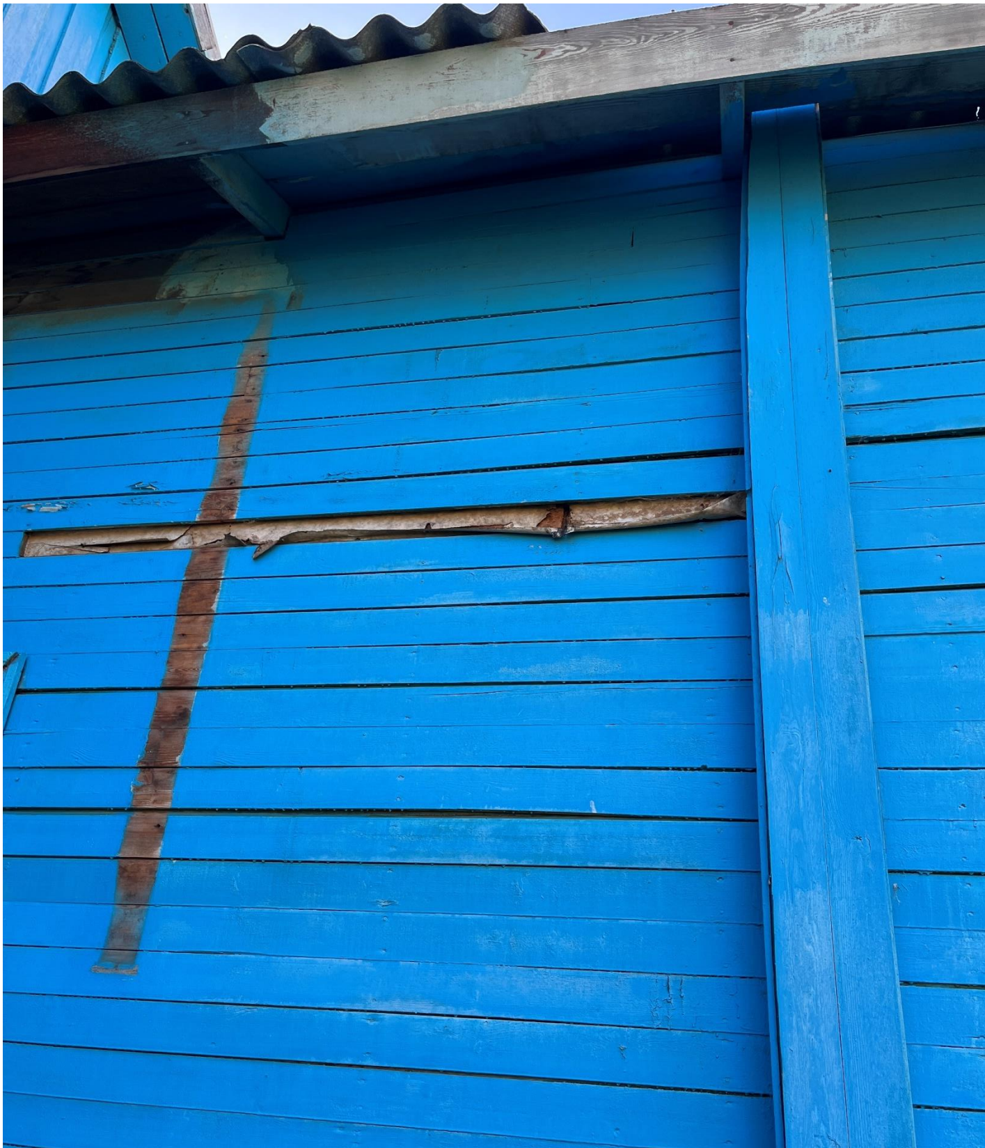
Изображение 23. Оголение гидроизоляционного слоя стен, вследствие деформаций дощатой обшивки наружных стен здания.
