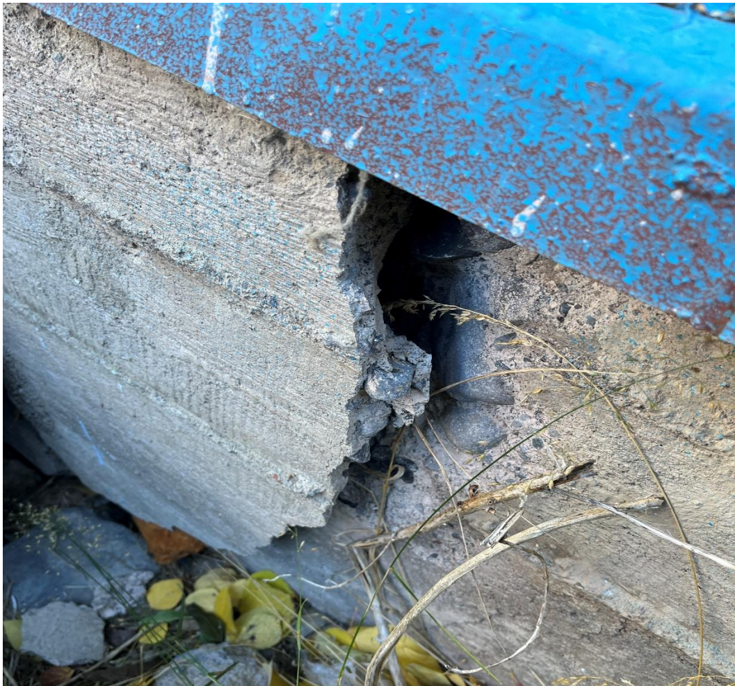
Изображение 14. Образование поперечных трещин в цоколе с шириной раскрытия более 3 см
