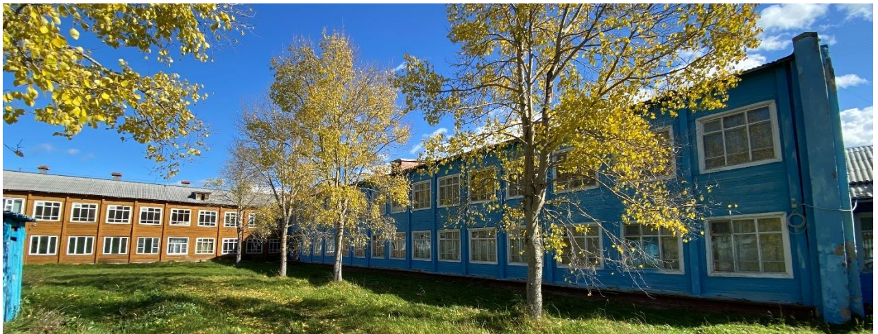
Изображение 6. Общій вид части фасада здания в осях 10-4
