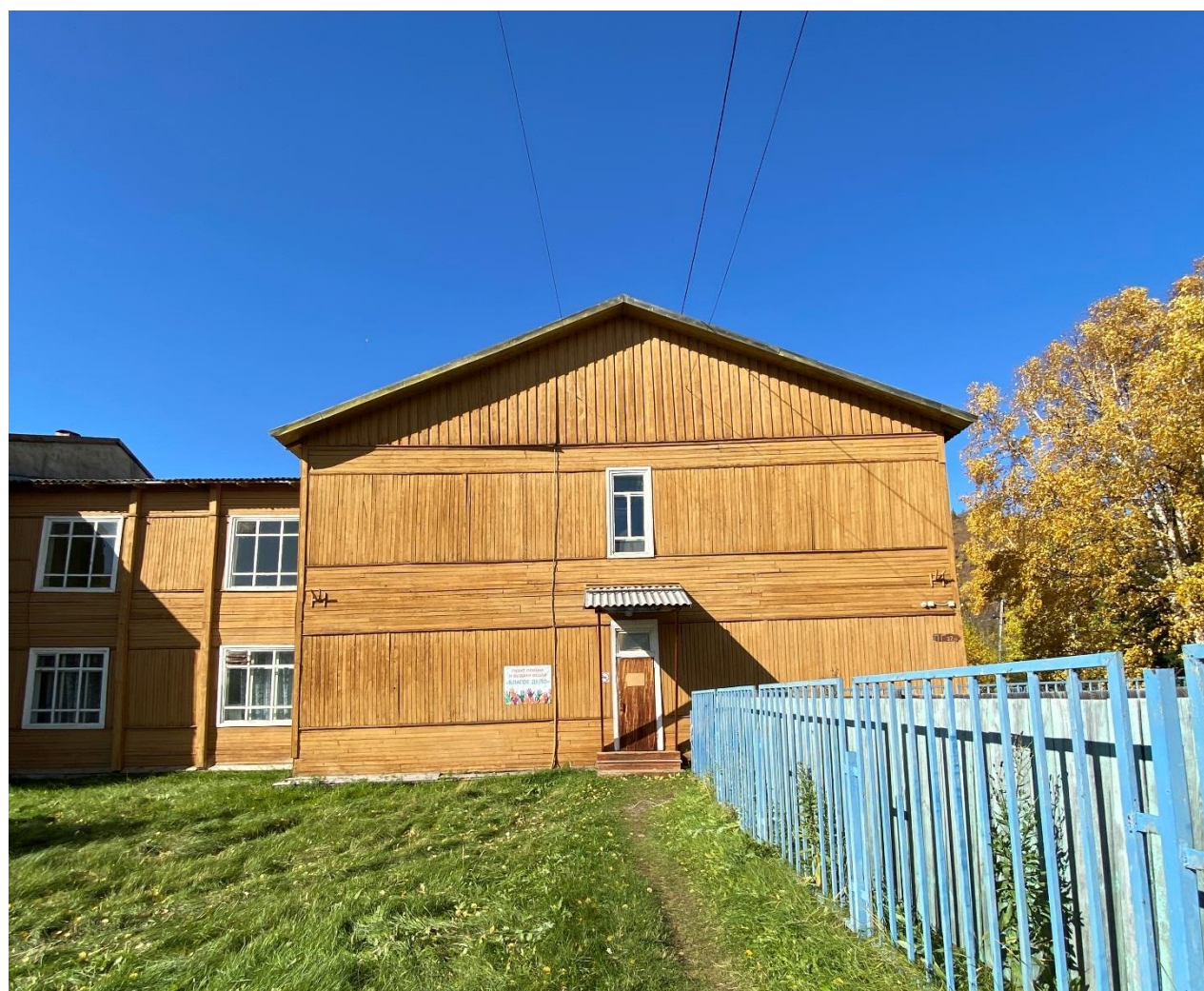
Изображение 10. Общий вид части фасада здания в осях 10-15
